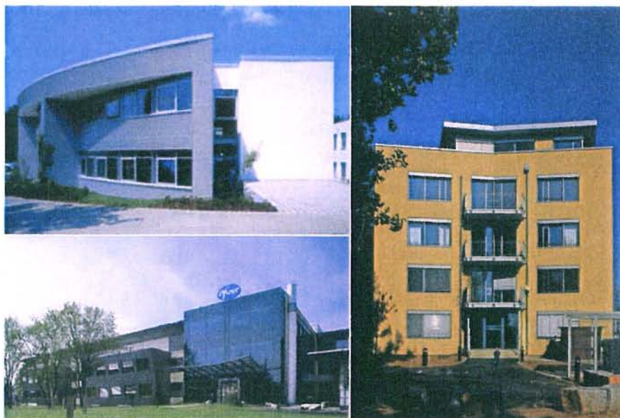
Abbildung 2: Die Energiekonzepte des Bürogebäudes von DS-ABT in Stuttgart, des Büro- und Laborgebäudes SPRING von Pfizer in Freiburg sowie des Bürogebäudes Wenzinger Hof in Freiburg werden messtechnisch evaluiert. Fotos: Drees & Sommer, Pfizer, UNMÜSSIG.
